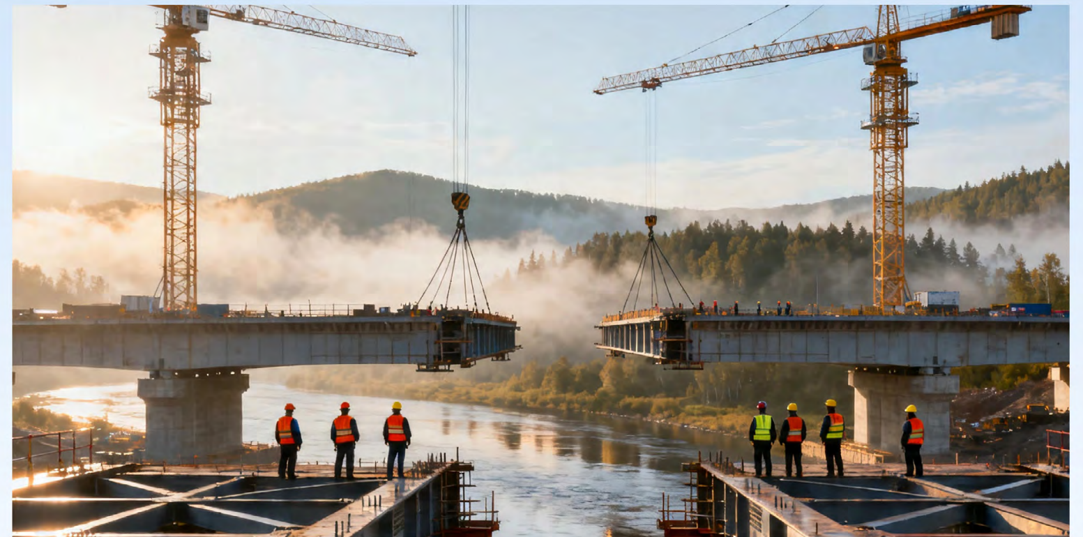
朝俄国境公路桥连通作业进行
