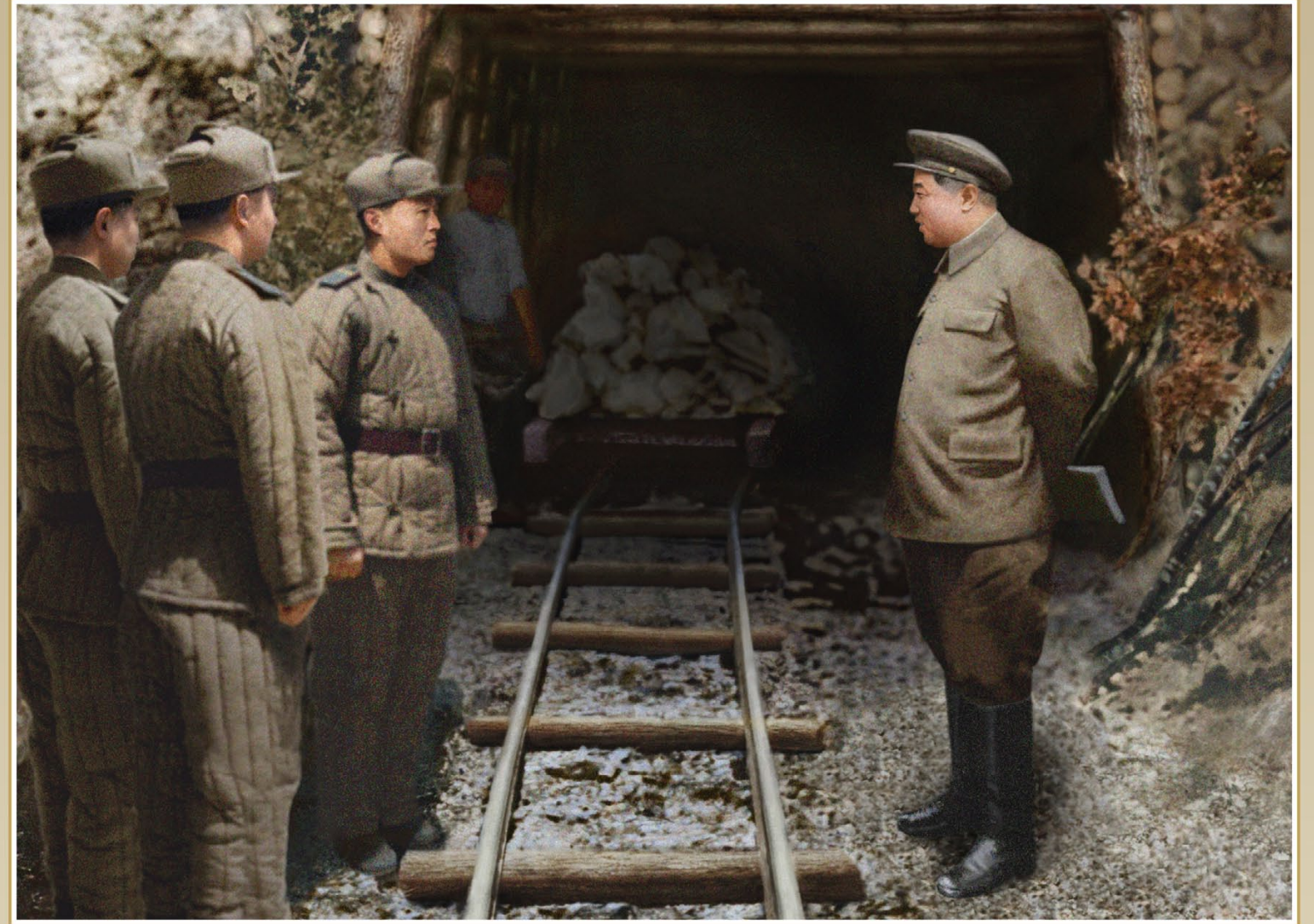
Kim Il Sung s'entretient avec des militaires sur le chantier de construction d'une galerie (octobre 1951).
