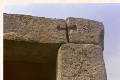
Структура соединения углов старинной обсерватории Чхонсондэ в Кэсоне.
