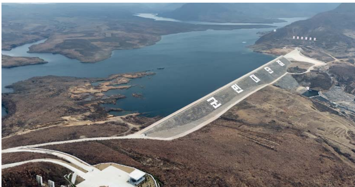
В ноябре 2025 года вошла в эксплуатацию Хвэянская ГЭС «Армия и народ». Это плод патриотической преданности и упорных усилий жителей провинции Канвон и военнослужащих.
