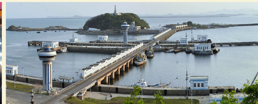
Durante corto lapso de un lustro se construyó el Complejo Hidráulico del Mar Oeste a lo largo de 8 kilómetros del mar.
